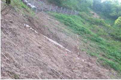
【着手前】落石防護柵
