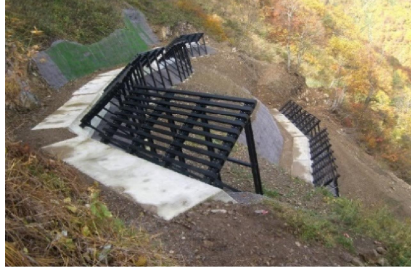
【H25完成】落石防護柵
