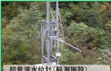
超音波水位計(観測施設)
