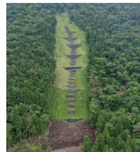
⑧ 立山工区復旧状況(遠景)
