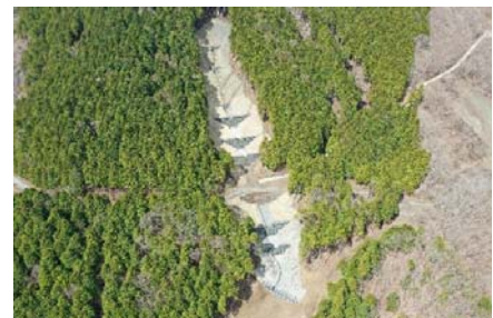
⑤ 角取山工区復旧状況(近景)
