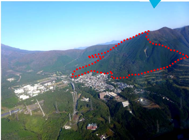
① 須走区域全景(事業区域及び保全対象)
