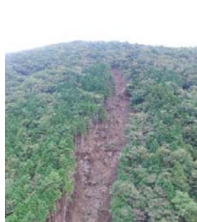
⑦ 立山工区荒廃状況(遠景)
