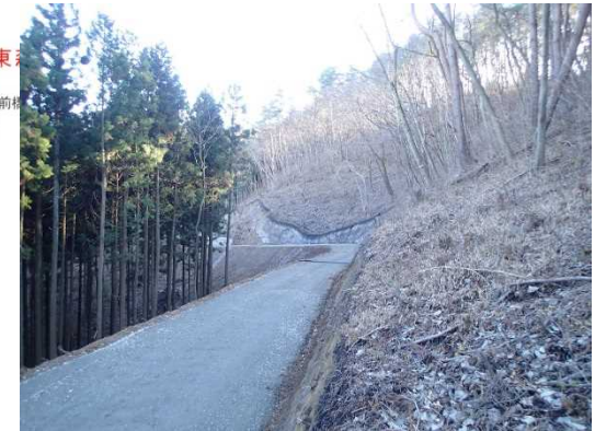
林業専用道の新設
