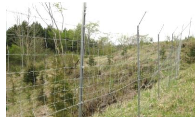
軽量金網柵を設置した様子（富士）
