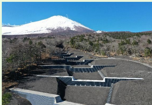
床固工により復旧(R4.12)
