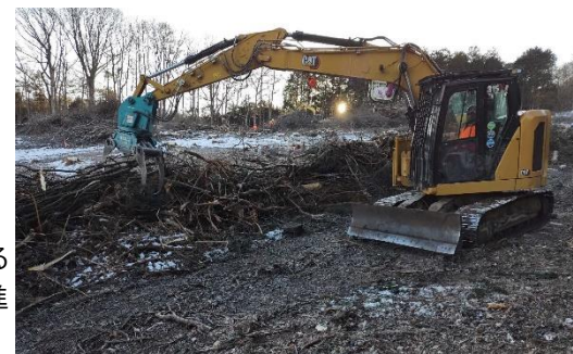
一貫作業システムによる 低コスト施業の推進 (利根上流)
