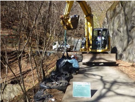
路肩欠損による道路被害防止 のための応急作業
