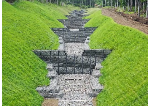
階段状に施工された枠式治山ダム工
