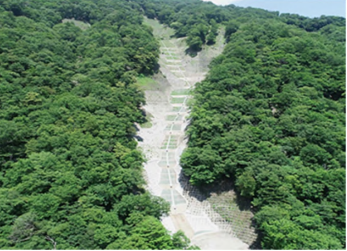
大規模崩壊地の復旧状況
