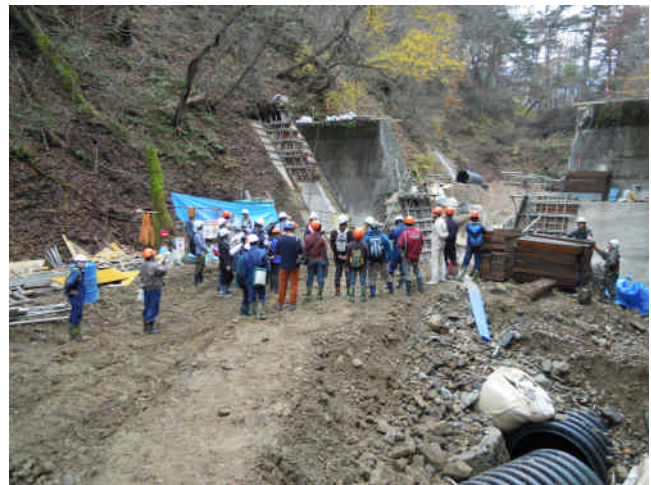
治山ダムの中央部撤去工事等を説明
