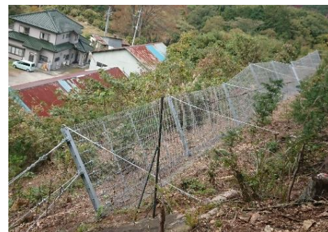
小原地区予防治山工事
