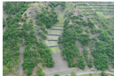
下桐久保沢地区復旧治山工事
