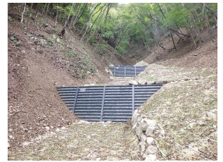
山腹工完成状況
