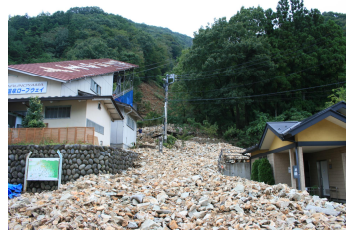
被災直後の状況
