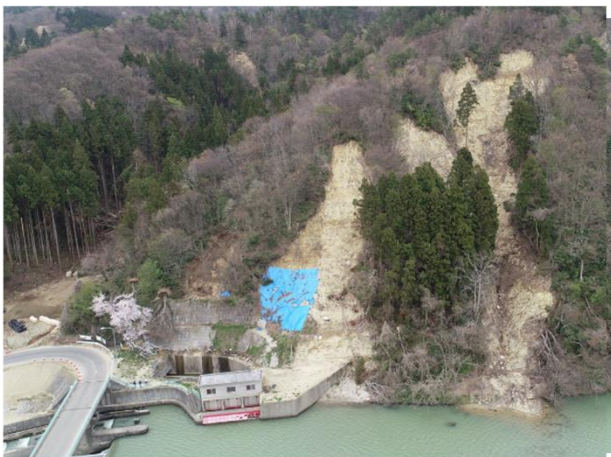
村上市小岩内（頭首工付近）【復旧前】
