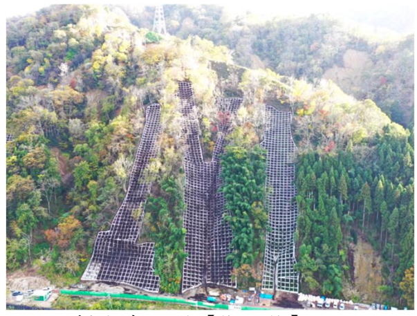
村上市貝附【復旧後】
