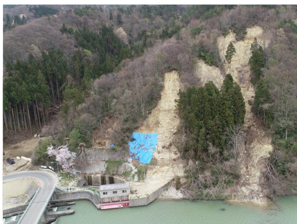
村上市 小岩内 頭首工（復旧前）
