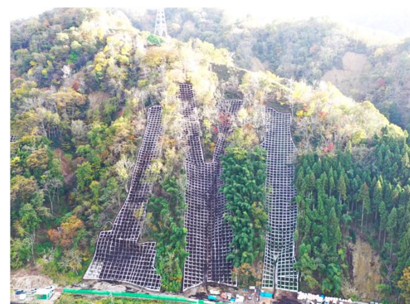
村上市 貝附（復旧後）
