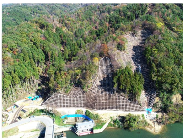
村上市 小岩内 頭首工（復旧後）
