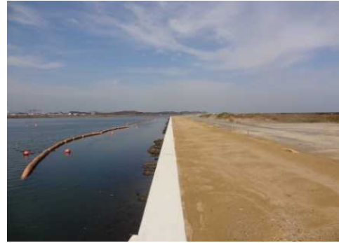
護岸工(施工後)
