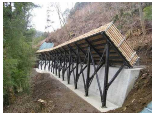
間伐材を利用した治山工事
