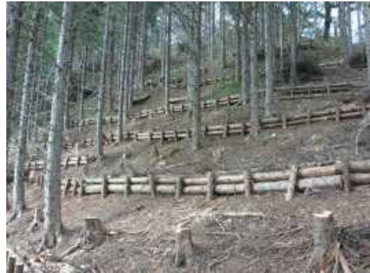
間伐と併行し、土砂流出防止対策として設置した簡易丸太筋工(実証事業)
