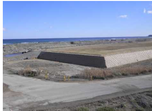
盛土工(施工後)
