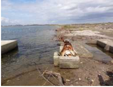
護岸工(施工前)
