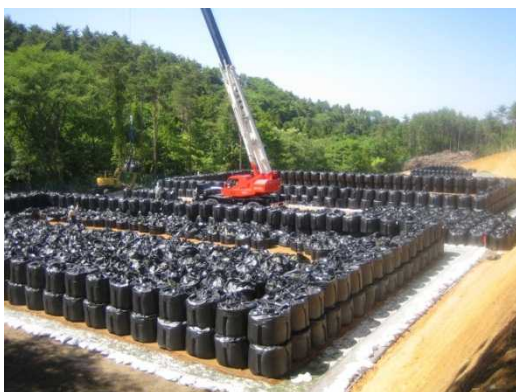
大型土嚢袋の搬入状況(福島県内国有林)
