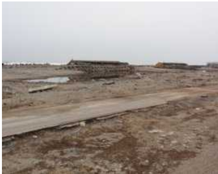
盛土工(施工前)
