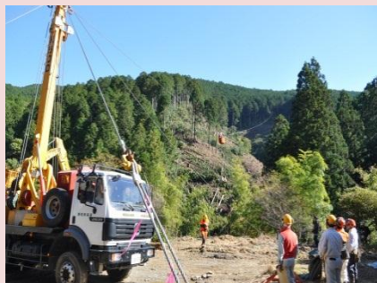
架線系作業システム
