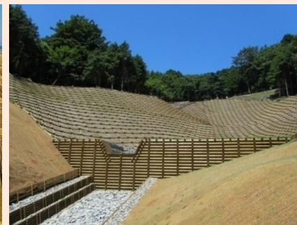
間伐材を利用した治山工事
