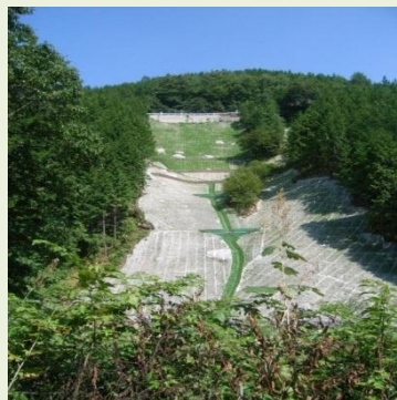
荒廃山地の復旧整備
