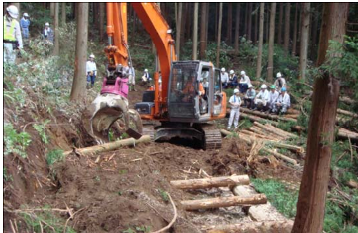
森林作業道作設現地研修会での丸太組の実演
