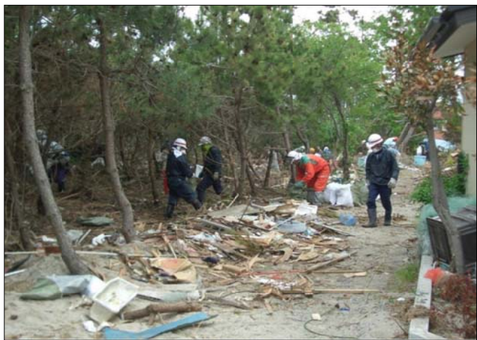
写真4 いわき市新舞子海岸防災林での瓦礫撤去作業
