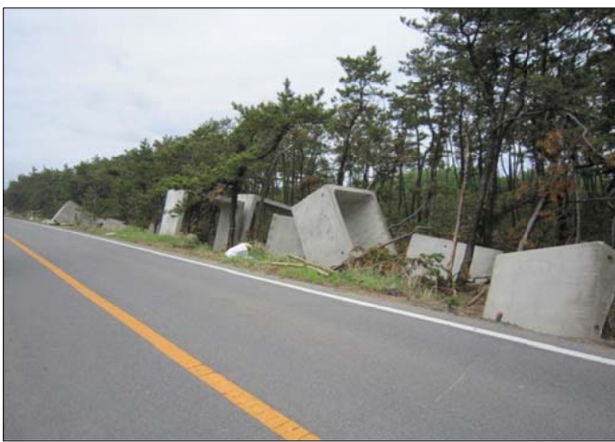
写真3 いわき市新舞子海岸防災林の津波漂流物補足状況
