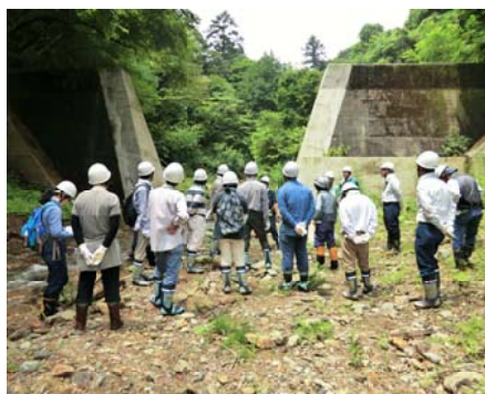
茂倉沢治山ダム改修工事について説明
