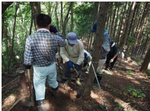
登山道階段整備作業中
