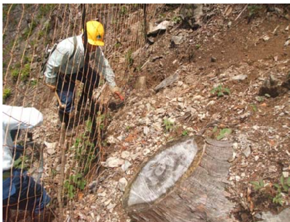
防護ネット修理の様子
