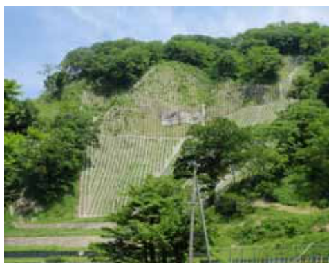
法枠工などの工事が行われている 「貫（つなぎ）地区」の現場
