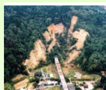
小千谷市浦柄被災状況 (平成16年10月撮影)
