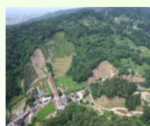
小千谷市浦柄完了状況 (平成19年7月撮影)
