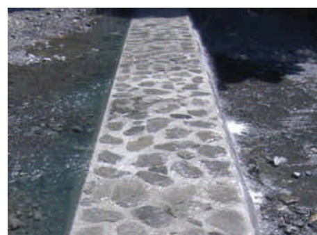
放水路の摩耗防止
