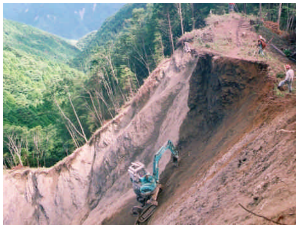
高所法面掘削機の作業状況 1
