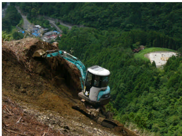
高所法面掘削機の作業状況 2
