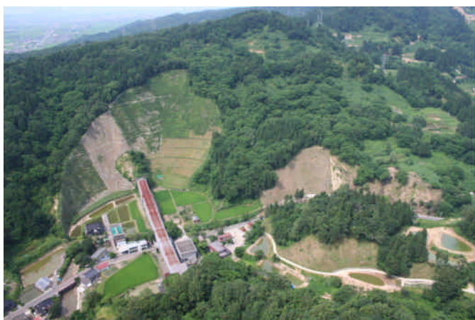
1 小千谷市浦柄「浦ノ山地区」完了状況 （平成19年7月撮影）
