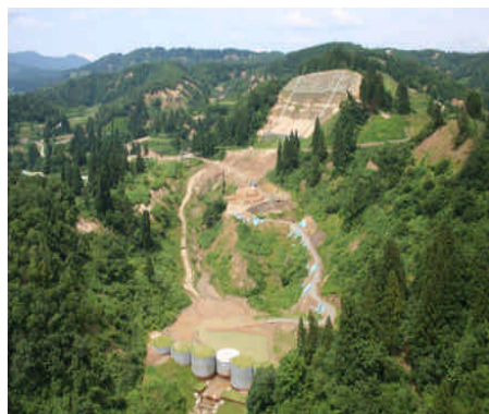
3 長岡市山古志「樺ノ木地区」復旧状況
