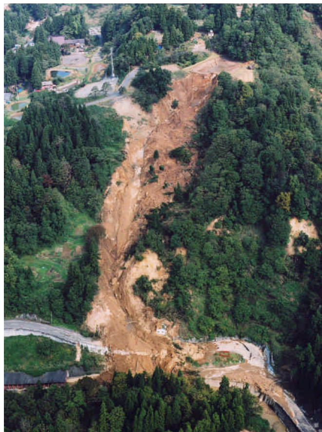
2 小千谷市小栗山「呼坂地区」被災状況 (平成16年10月撮影)
