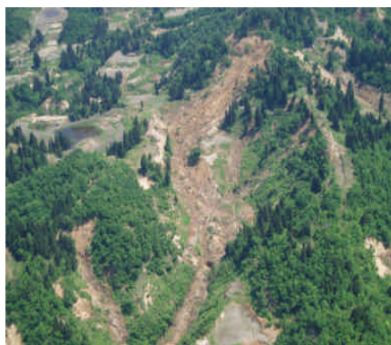
3 長岡市山古志「樺ノ木地区」被災状況 (平成17年6月撮影)
