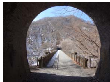
6号トンネルから5号トンネル
