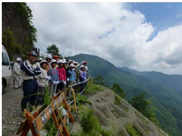
ゴボウ薙工事箇所見学
