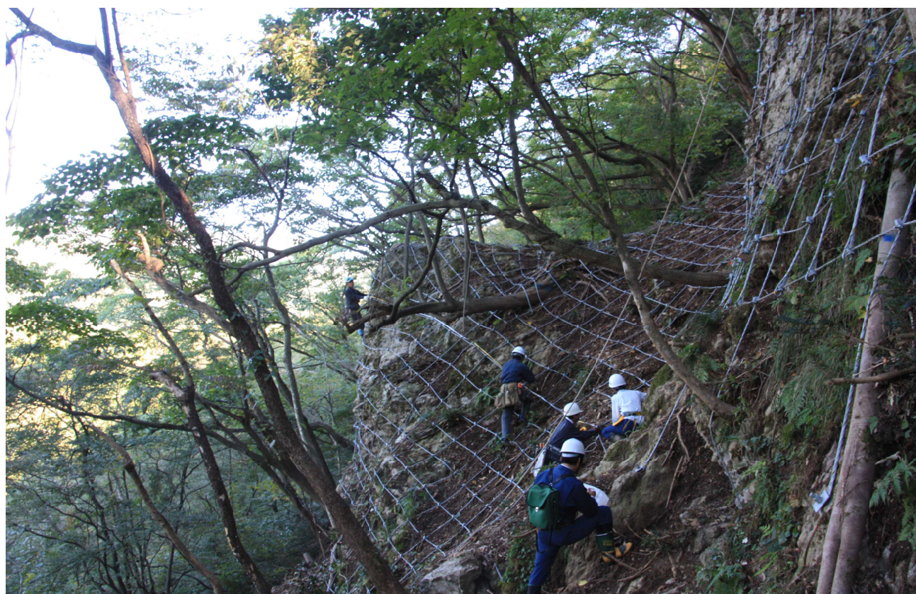
「落石防護柵工（ロープ伏工）」（新潟県胎内市） （撮影者：下越森林管理署）
