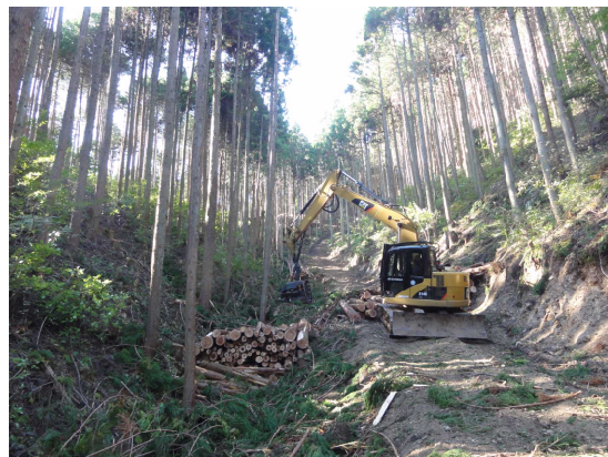
保育間伐活用型作業風景
