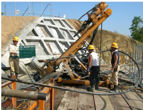
アンカー工施行状況(呼坂地区(小千谷市小栗山))不動地盤まで挿入した鋼材で地すべりを固定
