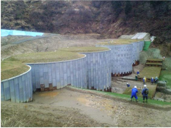
鋼製ダム(セルダム)
