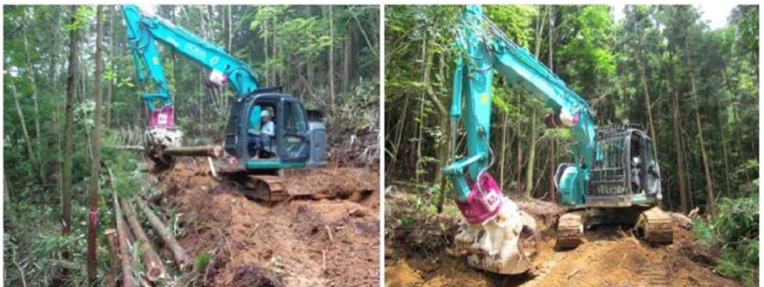
フェラーバンチャ付きグラップルバケットによる森林作業道開設
