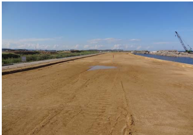
盛土が完成した状況(今後、植栽を予定)
