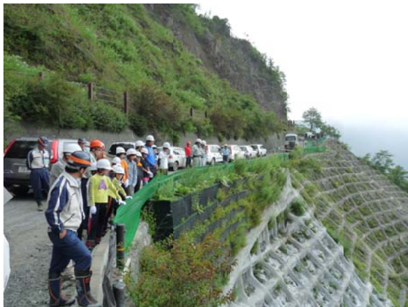
ゴボウ薙工事箇所見学
