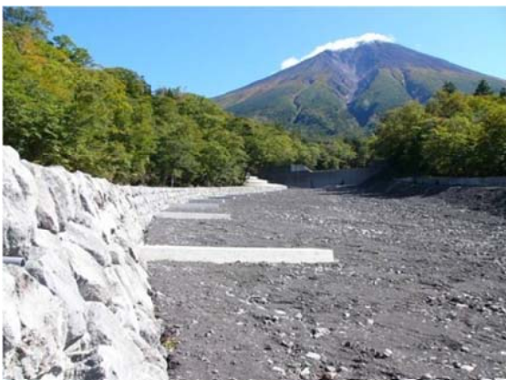
景観に配慮した自然石を利用した護岸工
