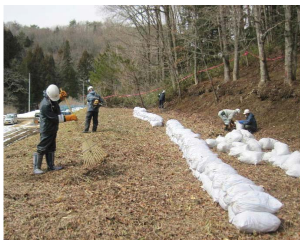
落葉等堆積有機物の除去 及び土のう袋への詰め込み
