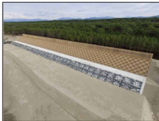
この工事は、海岸の森林を波浪等による侵食から防止するための防潮護岸工事の施工に際し、自然石のブロックを使用することでコンクリート量を減らすとともに、斜面を保護する木製法枠工や、強風から森林を守る木柵を防潮護岸に組み合わせさせて施工したもので、景観への配慮が評価されました。
