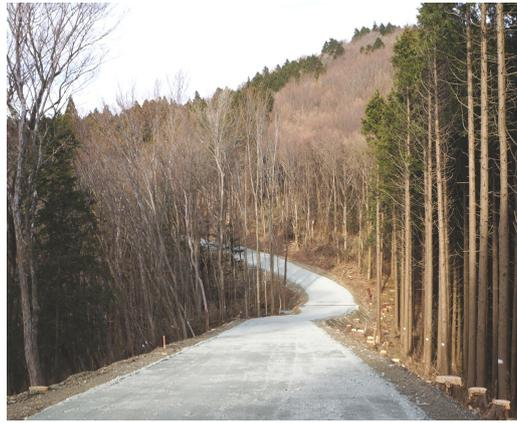
この工事は、起伏がある山の中で、費用のかかる構造物が少なくてすむよう、できるだけ緩斜面を通るよう設計されています。また、工事によって発生した余った土は、近くの路体の補強に有効利用し、運搬費用を縮減していることも評価されました。
