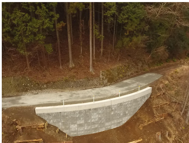
復旧工事による林道機能の回復
