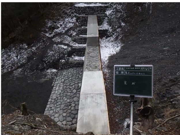
現地発生 of 巨石を利用した根固工、放水路保護
