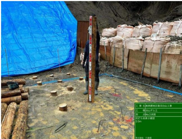
軟弱地盤に対しての杭基礎施工状況
