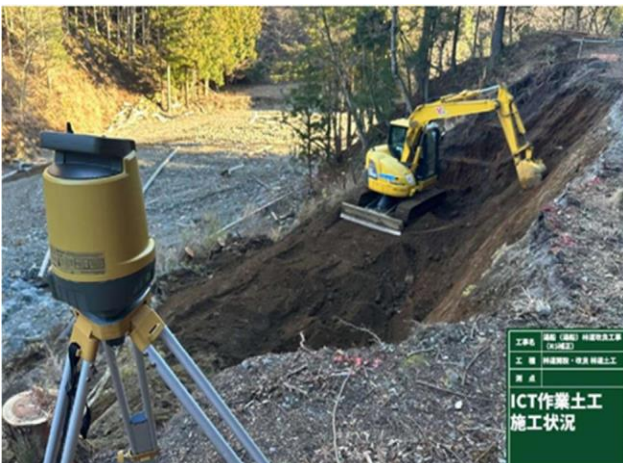
ICT作業土工の施工状況
