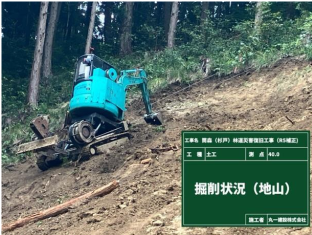
高所掘削機械（無人）での作業状況
