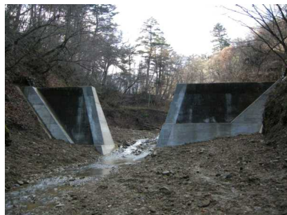
中央部を撤去した茂倉沢2号ダム
