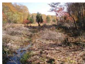
写真2 排水溝の状況
