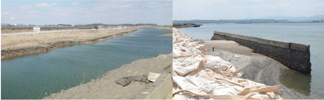
左：2013年(平成25年)3月撮影、海岸防災林の整備が始まる前の状況で、右側の堤防を超えた津波で地面が洗掘され、水が溜まっています。
