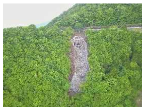
②⑦工事完了
