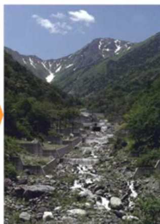
工事実施後(S62)
