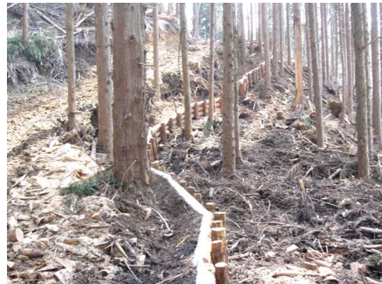
民地との境界付近に設置した丸太柵
