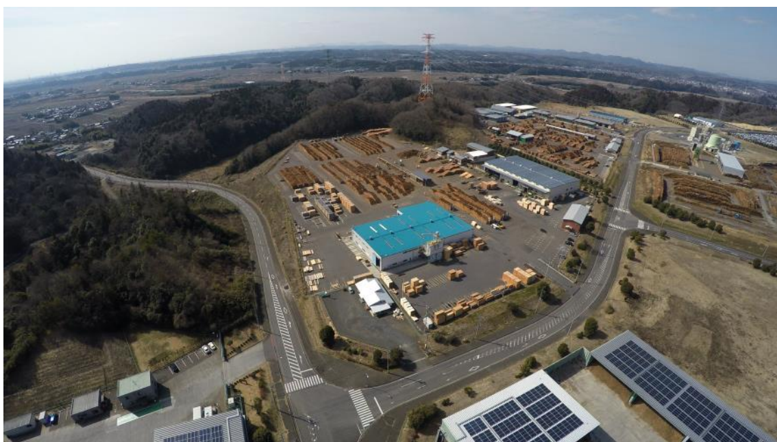
写真4 原木市場、製材工場、木質バイオマス発電所などが集積する宮の郷工業団地
