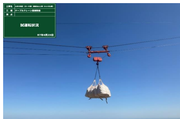
ケーブルクレーンによる資材運搬
