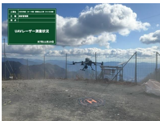
UAV（ドローン）測量実施状況
