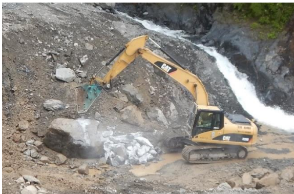
油圧ブレーカーによる転石の破碎
