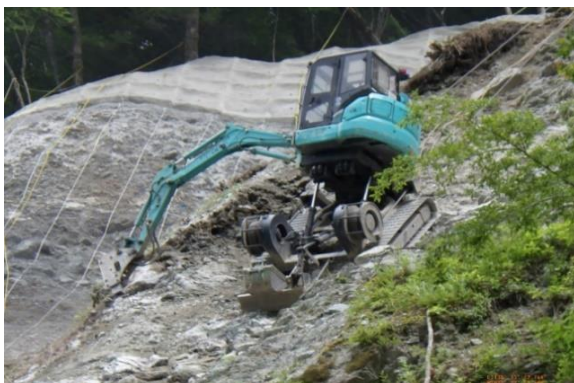
高所法面掘削機による法面整形作業
