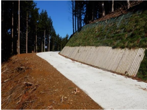
林道開設（黄金沢林業専用道）
