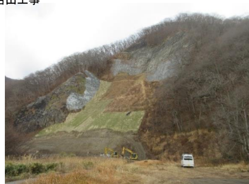
法面復旧（R7.11）
