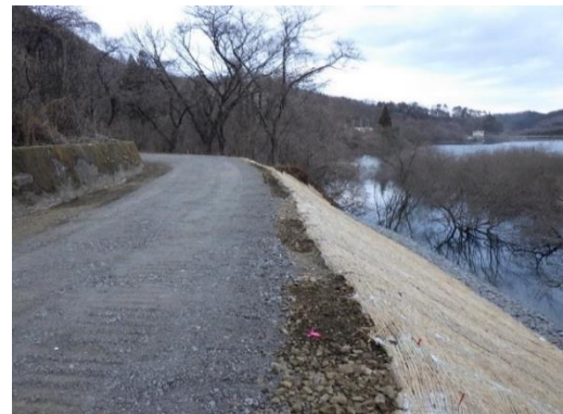
改良工事（旗宿・金山林道）
