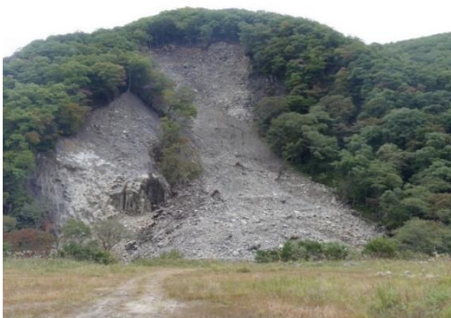
法面崩落災害（H23.7）
