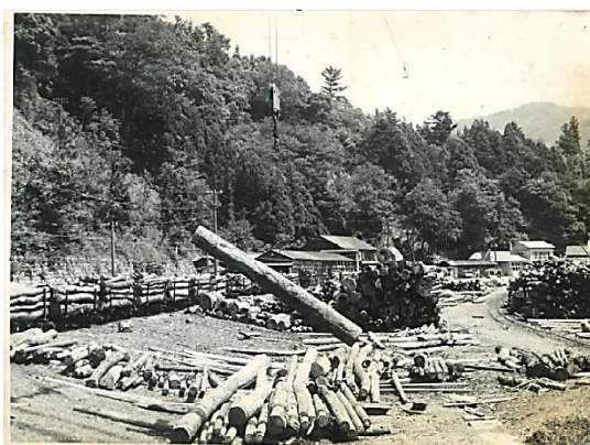
(貯木場の中央にケーブルで丸太の仕分けを行う)
