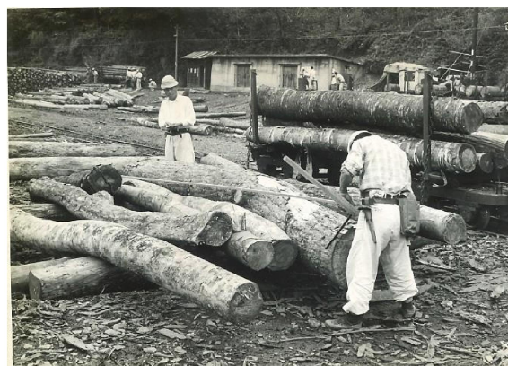
(丸太の計測 10 年程度の経験をもった作業員（検測手）が計測)
