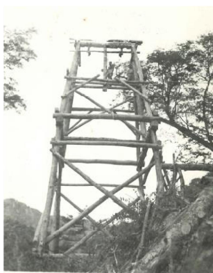
(大根沢索道 第5号支柱)
