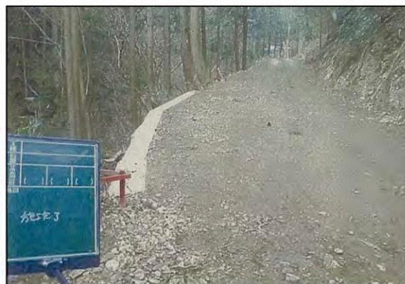
令和6年度に実施した大富林道改良工事（南相馬市）
