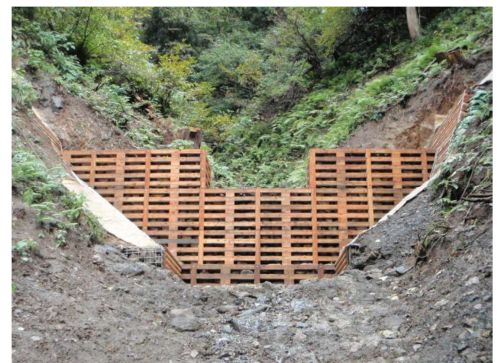
木材を利用した治山工事
