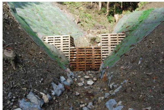
木製谷止工 完成
