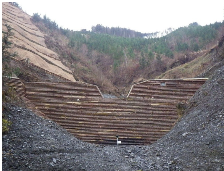
間伐材の使用による自然と調和した治山事業(鹿沼市)
