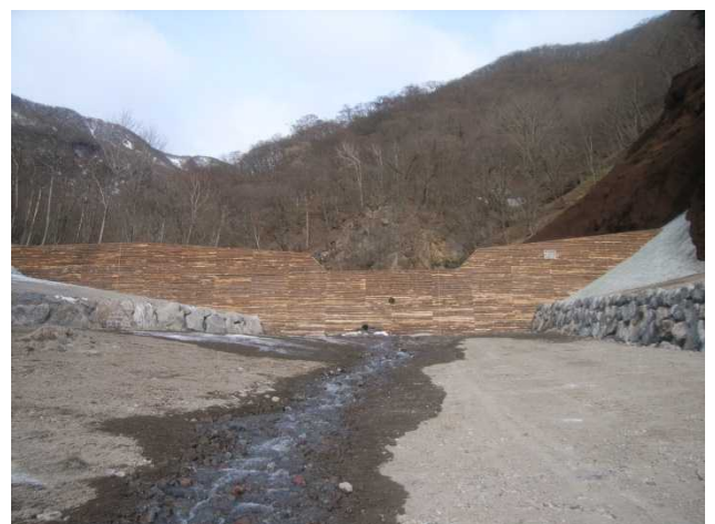
下流への土砂の流出を防ぐ治山事業(桐生市)
