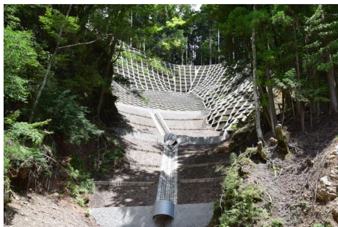
間伐材を使用した崩壊地の復旧(伊豆市)
